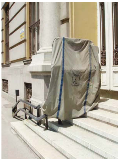
Sl. 1. Pristup stepenišnom platformom Glavnoj pošti u Sarajevu
