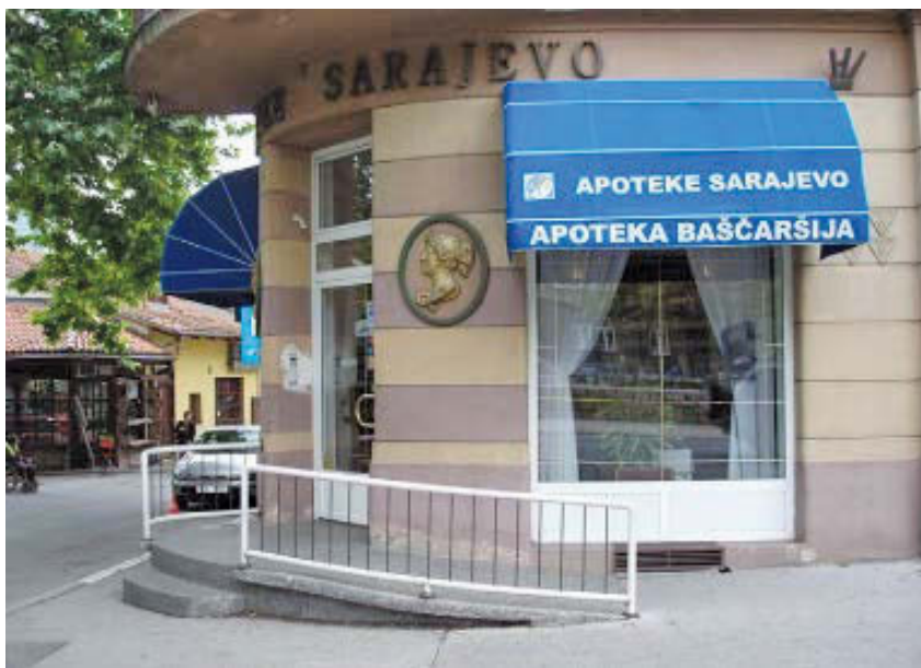
Sl. 3. Pristup kosinom apoteci (primjer iz Sarajeva)
