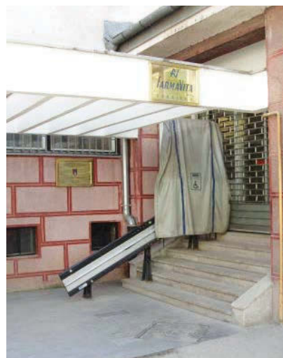
Sl. 2. Pristup stepenišnom platformom Zavodu zdravstvenog osiguranja Kantona Sarajevo – filijala Stari Grad
