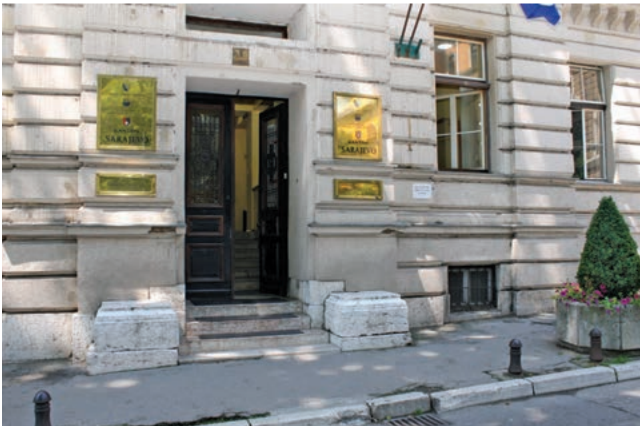
Neadekvatan pristup zgradi Kanonalne vlade u Sarajevu
